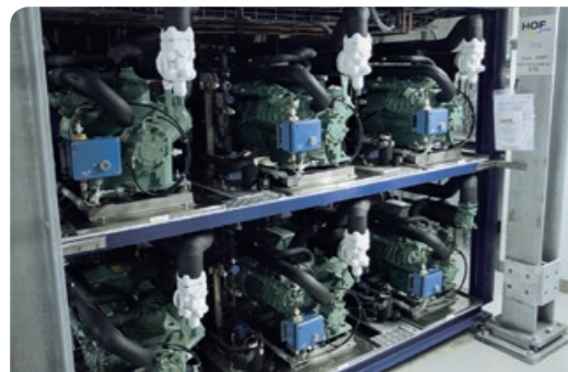
Abb.: Modulbau von sechs Kompressoren
