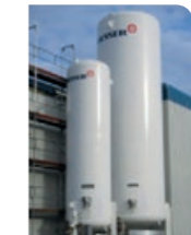
Abb.: Lagerung Stickstoff-Messer
